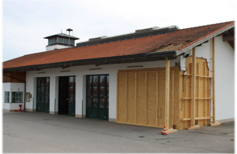
Außenansicht nach Reparatur
