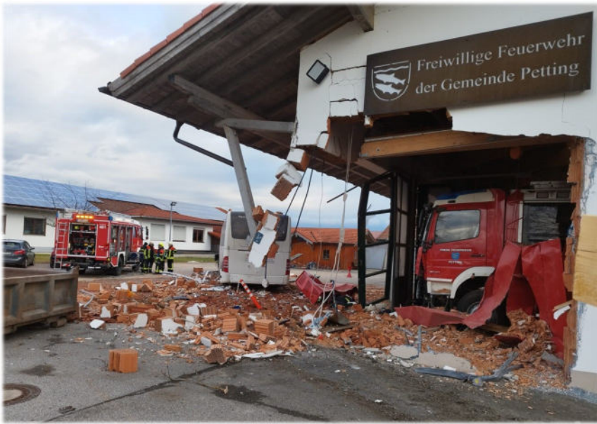
<- Schaden am Tag des Unfalles mit dem Bus im Hof der Alarmpausfahrt
